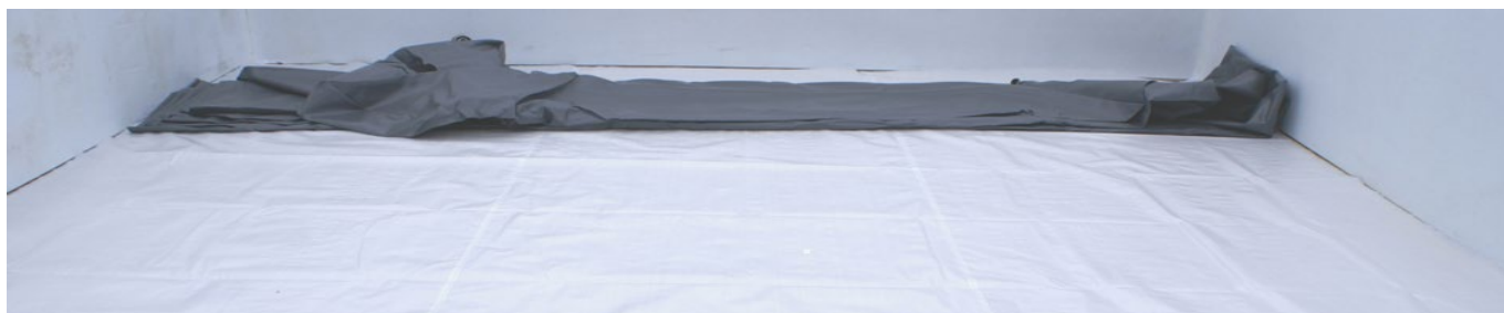
Figure 33 – Dépliage du liner
